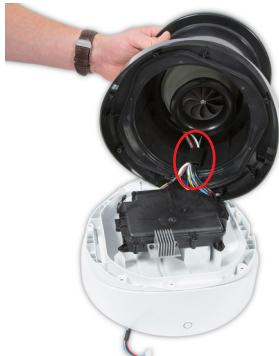
**124** Heben Sie die Kippplatte und das untere Gehäuse vorsichtig vom Hauptgehäuse ab.
